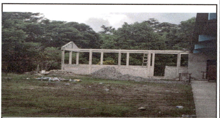
Foto 6: Terminacion de trabajo de colocacion de block Solera y Limpieza listo para colocar las estructuras y laminas
