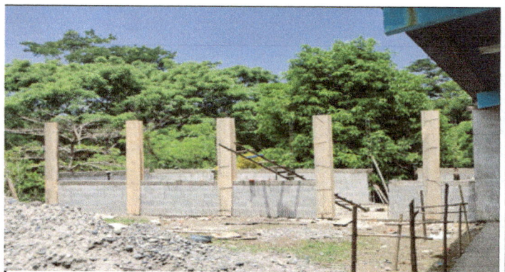
Foto 4: Fundicion de Columnas despues de colocar el block
