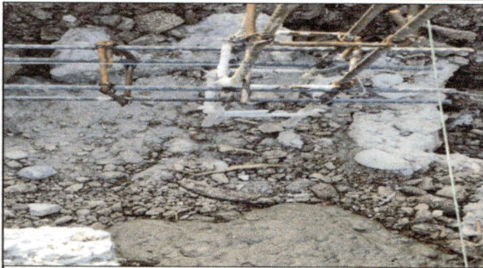
Foto1: Colocacion de columnas y soleras
