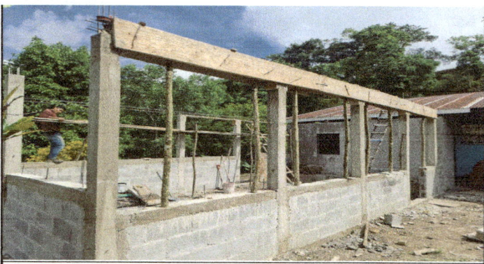
Foto 5: colocacion de solera final
